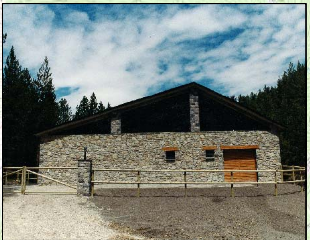
EDAR DE LA SUPERMOLINA
